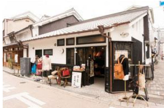
改装後の活用
